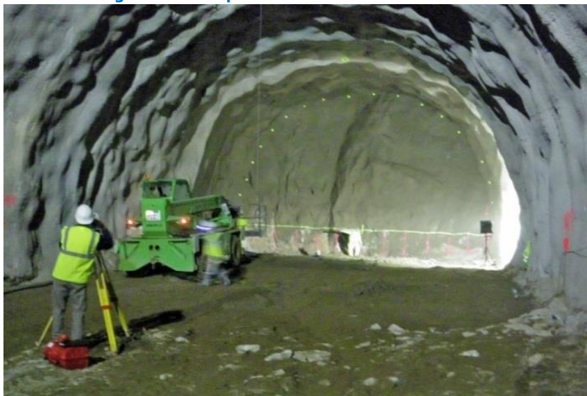
Figura 11.2 Replanteo del frente de excavación
