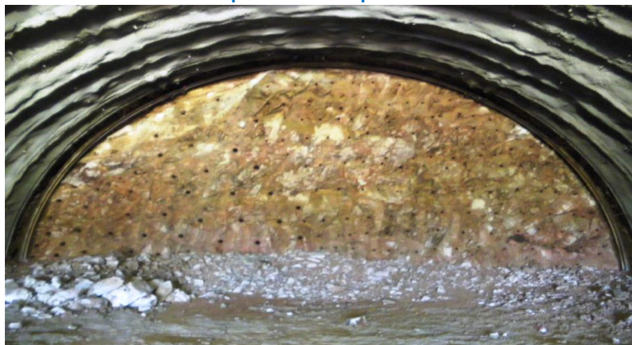
Figura 11.3 El plan de tiro se adapta según la calidad del terreno. la parte izquierda se perfora con un diámetro más grande porque necesita explosivo de más potencia
