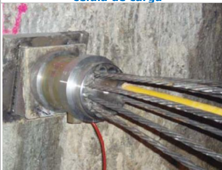
Figura 8.12 Instalación de una célula de carga
