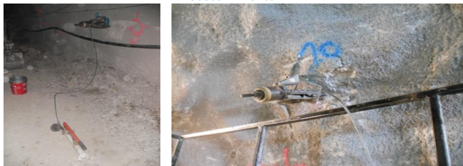
Figura 11.9 Comprobación de tensión en los pernos de anclaje en el sostenimiento
