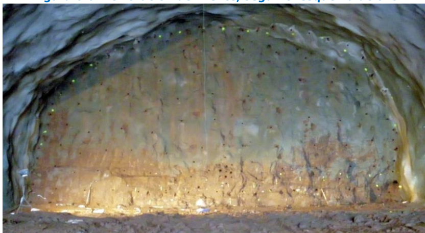
Figura 6.6 Perforación del frente, según el esquema de tiro
