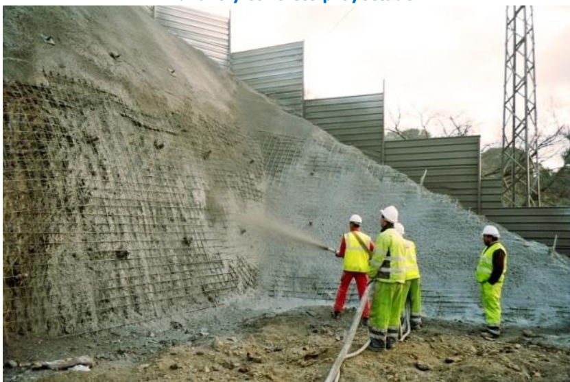
Figura 10.9 Protección del talud con la combinación de pernos de anclaje, mallazo y concreto proyectado
