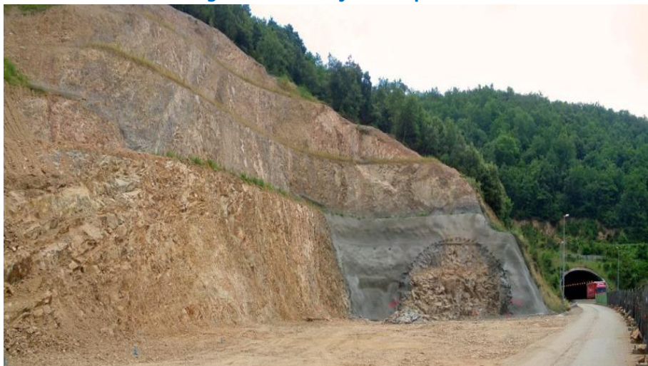
Figura 10.6 Encaje de un portal
