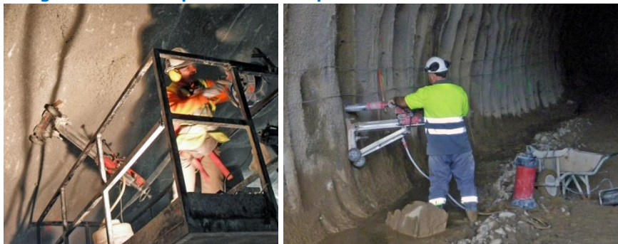
Figura 11.10 Comprobación de espesores durante el sostenimiento
