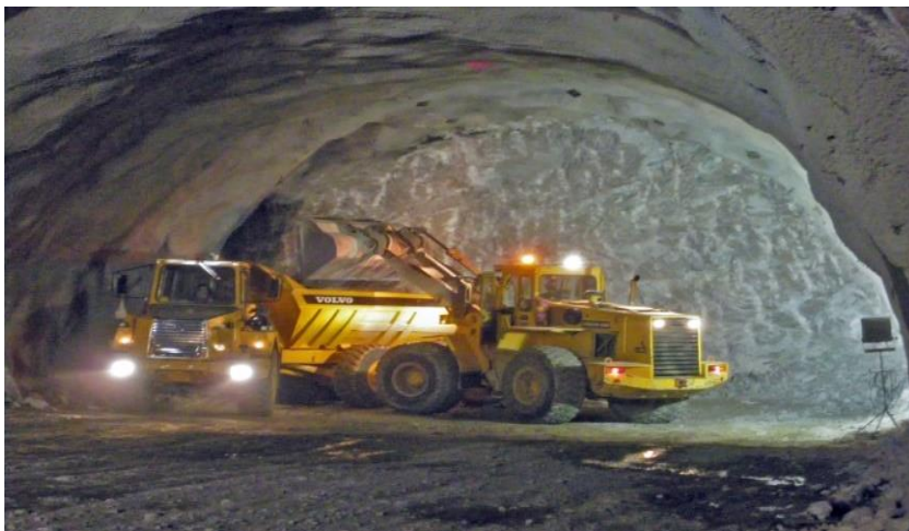
Figura 6.7 Retiro de escombros de la voladura, mediante pala cargadora y camión articulado
