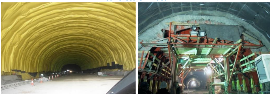
Figura 9.2 Lámina impermeabilizante de pvc y carro de encofrado de concreto en masa
