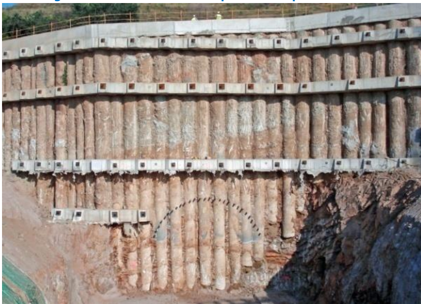
Figura 10.9 Protección del talud con la combinación de pernos de anclaje, mallazo y concreto proyectado
