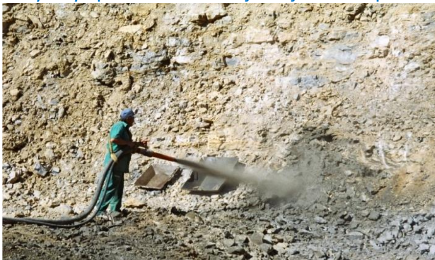
Figura 11.7 Ejecución de artesas de concreto lanzado durante las pruebas y ensayos previos durante los trabajos de ejecución en el portal
