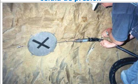
Figura 8.10 Instalación de una célula de presión
