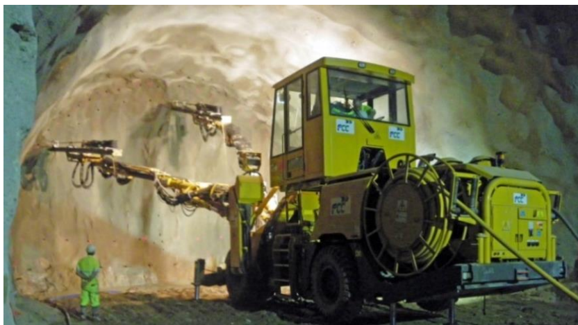
Figura 6.2 Maquinaria tipo jumbo perforando barrenos en el frente de excavación
