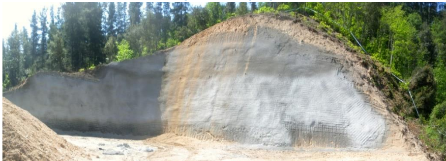
Figura 10.10 Protección del talud con la combinación de pernos de anclaje, mallazo y concreto proyectado.
