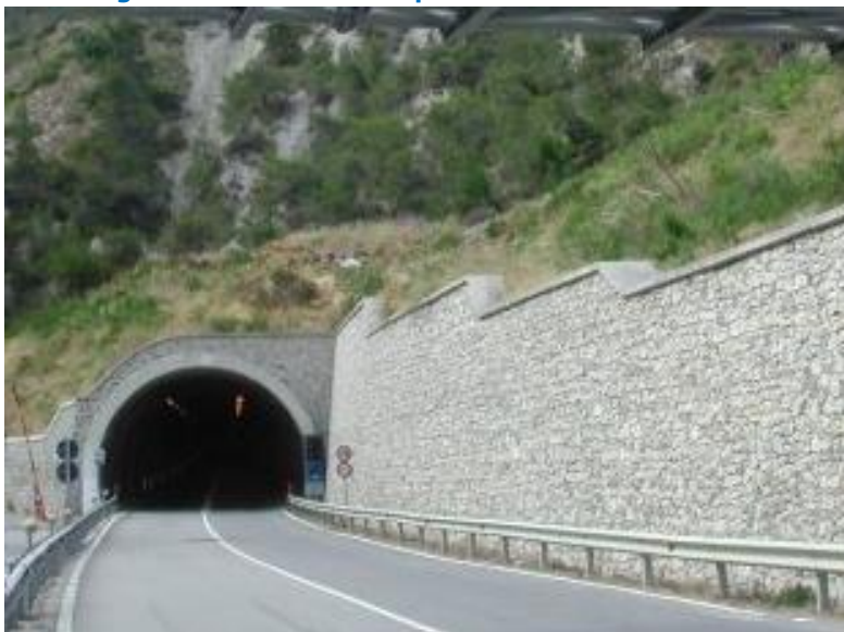
Figura 10.23 Portal con protección lateral del talud
