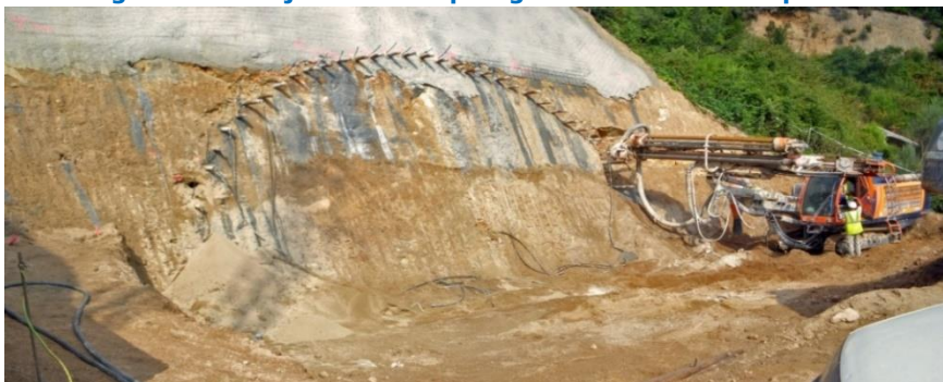
Figura 10.13 Ejecución del paraguas mediante micropilotes
