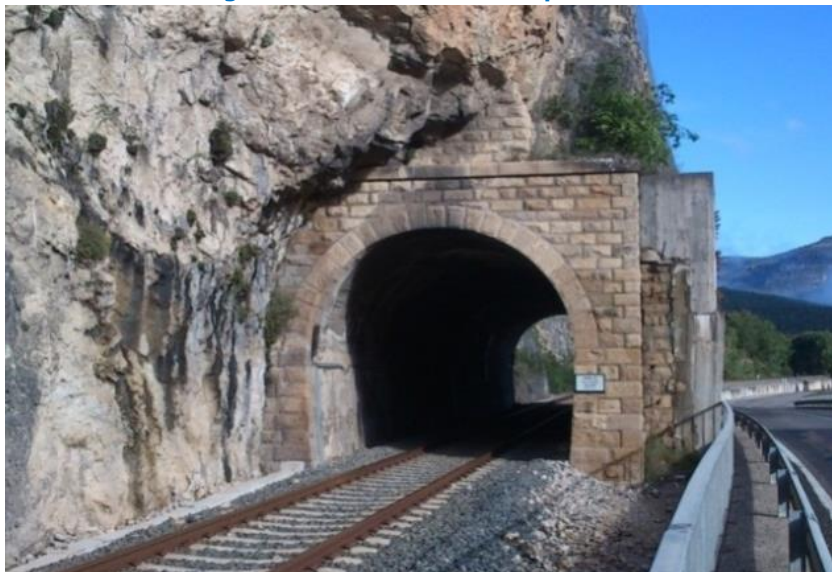
Figura 10.20 Portal de mampostería
