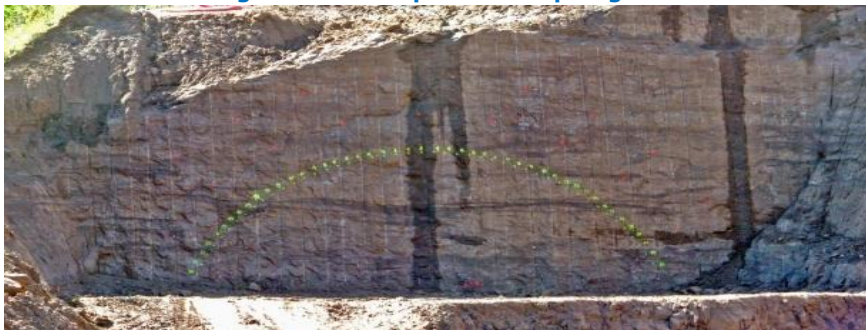
Figura 10.13 Ejecución del paraguas mediante micropilotes
