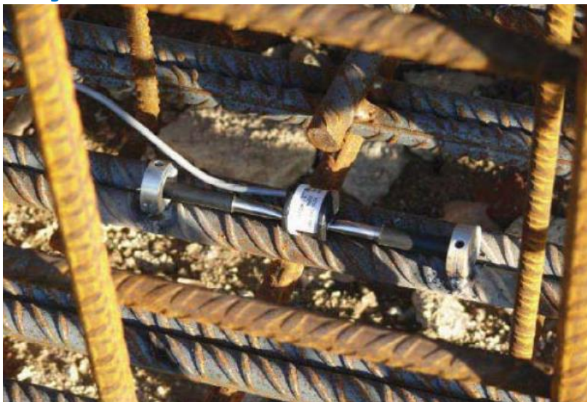
Figura 8.6 Instalación de un extensímetro de cuerda vibrante
