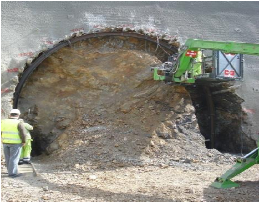
Figura 10.11 Excavación del frente en los primeros metros estabilizando el frente mediante machón central.
