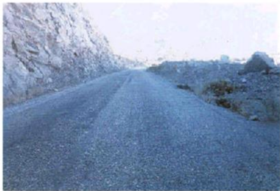
FOTO N° 1 Peladura Superficial FOTO N° 2 Exudación de Asfalto
