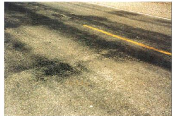
FOTO N° 1 Peladura Superficial FOTO N° 2 Exudación de Asfalto
