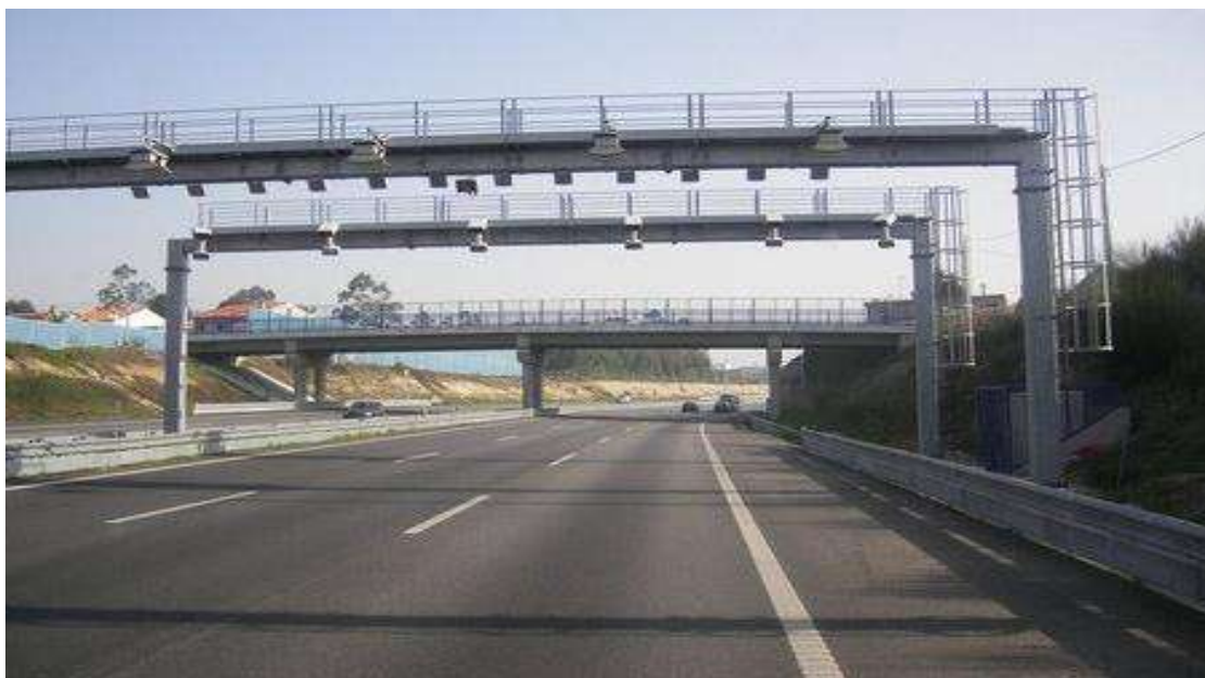
Figura 2.54 Ejemplo de pórtico con dispositivos de medición de velocidad como sistema inteligente de transporte (ITS)
